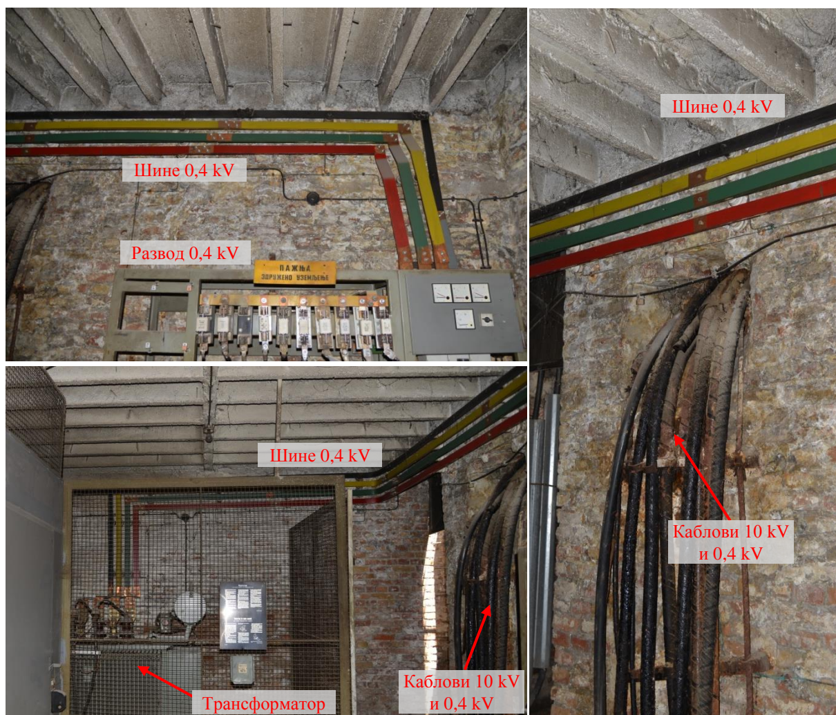
СЛИКА 2 – Распоред опреме у трансформаторској станици
